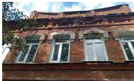
Фрагмент главного (Южного) фасада на уровне 2-го этажа
