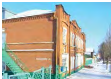
Вид на Западный и Южный фасады
