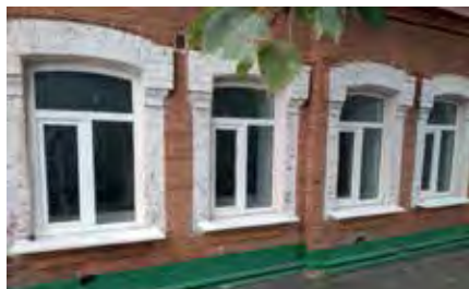
Фрагмент главного (Южного) фасада на уровне 1-го этажа
