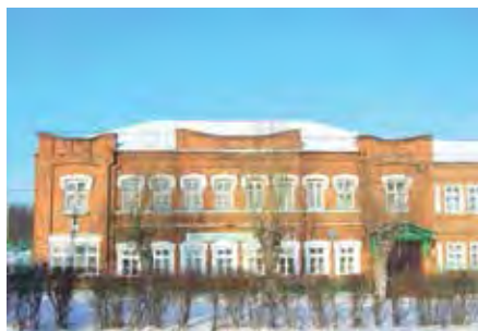
Главный (Южный) фасад
