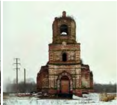
Западный фасад (притвор)
