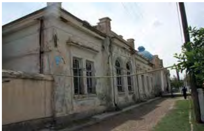
Рис. 3. Состояние главного фасада бывшего Консульство России (2022 г.); техническое состояние стены из сырцового кирпича местами разрушенное
