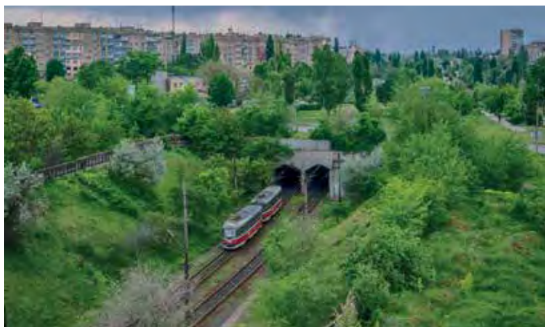
Рис. 1. Портал тоннеля метроtramвая на перегоне « Вечерний бульвар» — «Городская больница» в городе Кривой Рог
