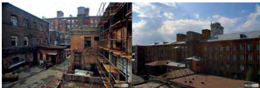
Рис. 2. Состояние сооружения до реконструкции.
