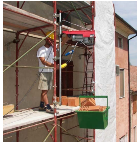
Рис. 10. Применение электрической лебедки в строительстве
