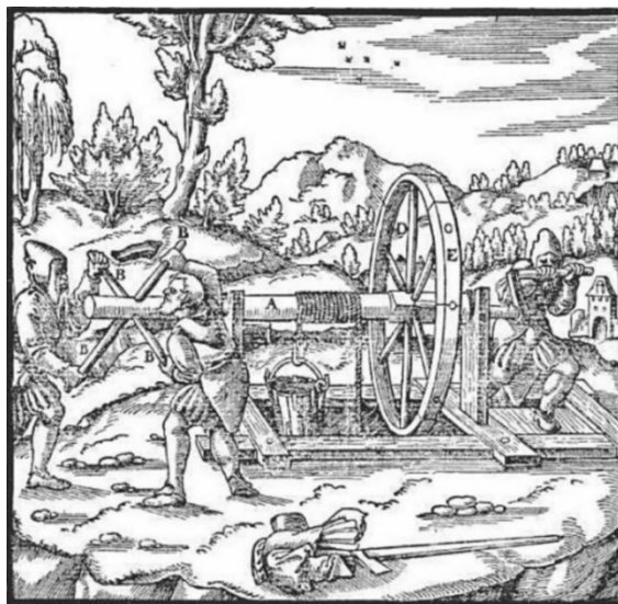
Рис. 3. Применение горизонтальной лебедки для подъема воды
