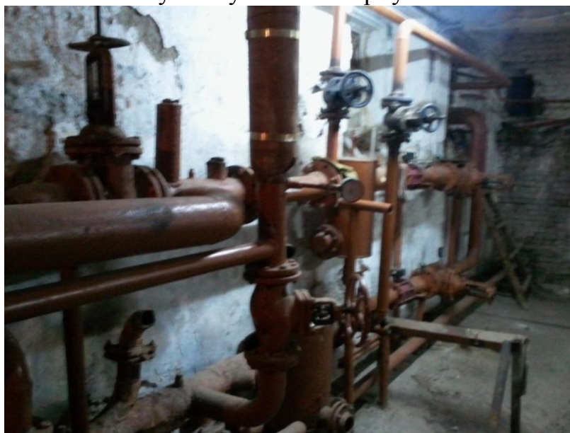
Рисунок 1 – Существующий тепловой пункт учебного корпуса №1
