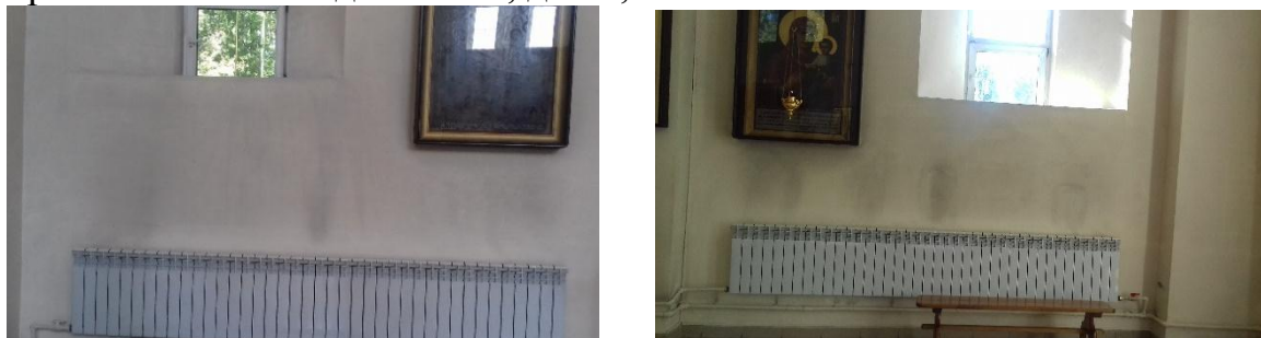
Рисунок 1 – Общий вид загрязнения внутренней поверхности стены и икон над отопительным прибором
