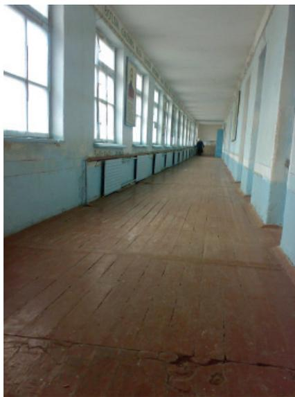
Рис. 4. Общий вид коридора здания школы № 24 Гиждуванского района с продольными несущими стенами, где не имеются поперечные рамы жесткости здания
