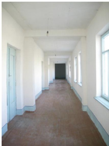
Рис. 5. Общий вид коридора здания школы № 31 Шафирканского района с поперечными несущими стенами; техническое состояние здания удовлетворительное
