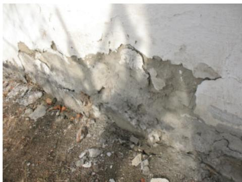
Рис. 2. Последствие ненадежной горизонтальной гидроизоляции стен здания школы цементным раствором
