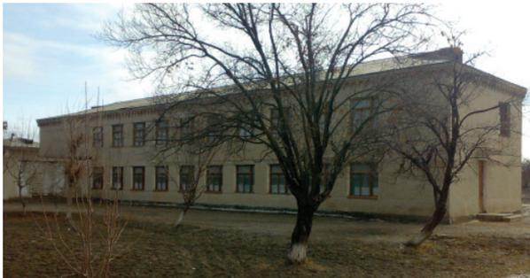
Рис. 8. Общий вид первого блока главного корпуса школы № 38 Шафрианского района из силикатного кирпича
