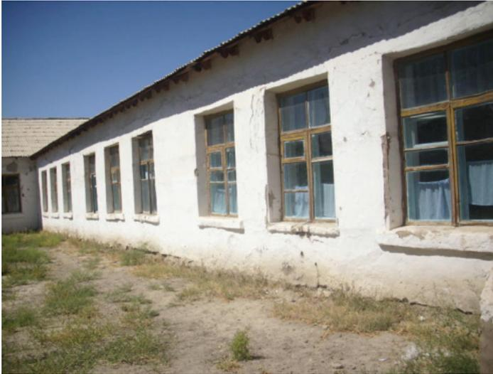
Рис. 10. Фрагмент наружной стены школы № 16 Шафриканского района из сырцового кирпича; техническое состояние неудовлетворительное
