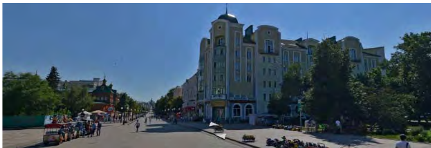
Рис. 5. Жилой дом по улице Московской на площади Белинского в городе Пензе
