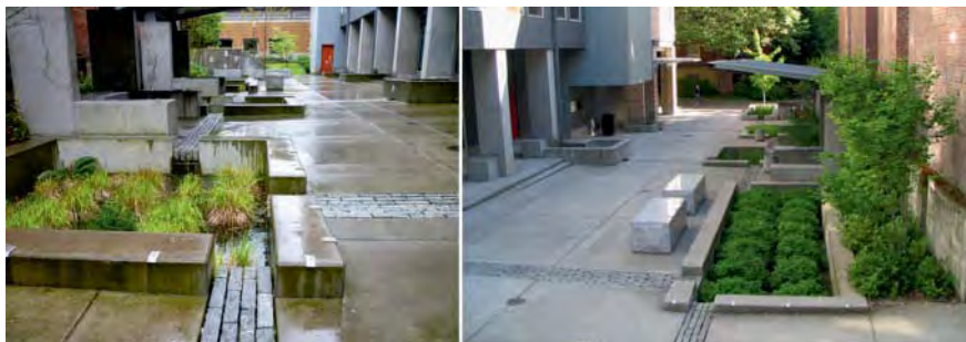
Рис. 7. Элемент дренажной ливневой системы, организованный с помощью мощения
