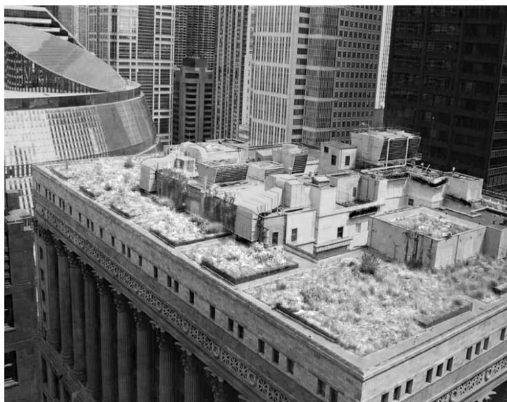
*Рисунок 3 – Озеленение крыши офисного здания*
