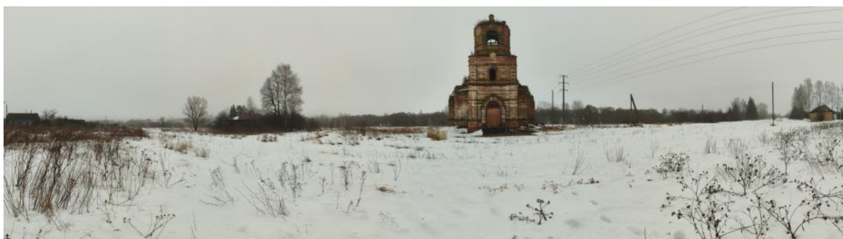
Рисунок 8. Панорама объекта с видимым понижением рельефа с западной стороны
