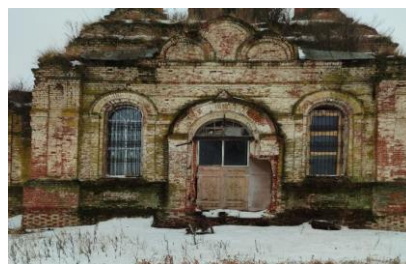
Точка фотофиксации №3. Вид на боковой притвор северного фасада
