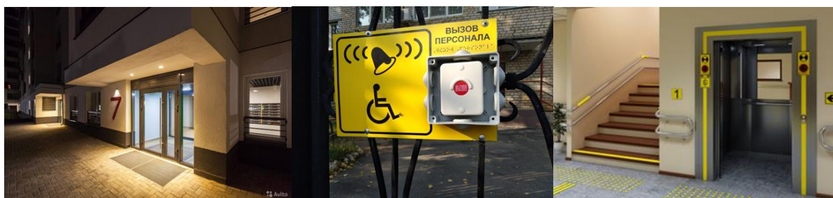
Рисунок 2. Примеры современных требований к объектам архитектурной среды
