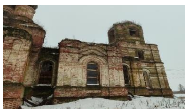
Точка фотофиксации №4. Вид на звонницу северного фасада
