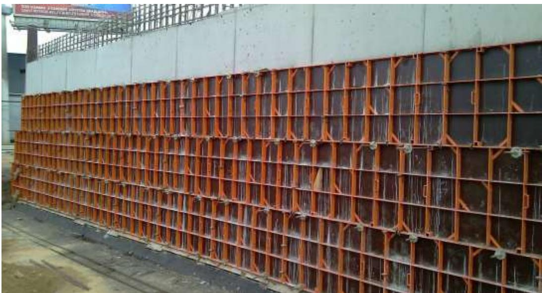
Рисунок 2 – пример мелкощитовой опалубки
