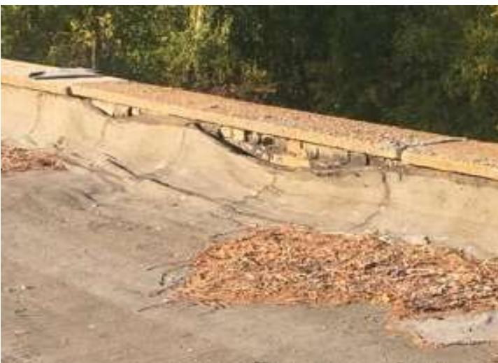
Рисунок 3 – Образование складок, прогибы и сползание кровельного ковра
