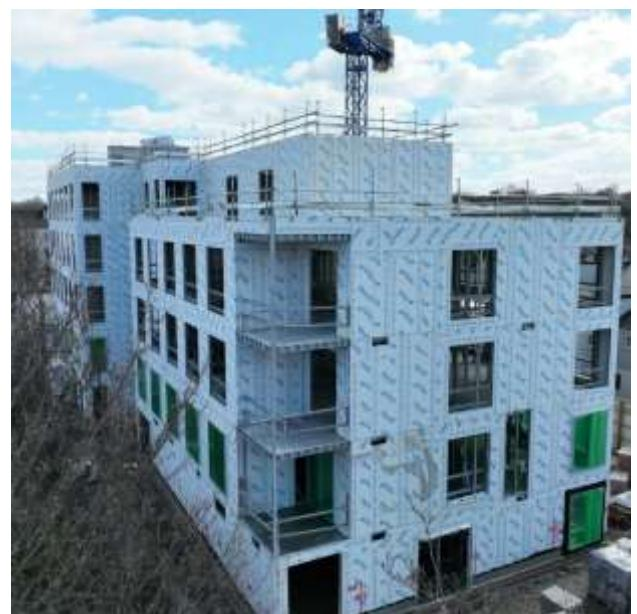
Рисунок 1 – Процесс возведения многоквартирного жилого дома из металлического каркаса
