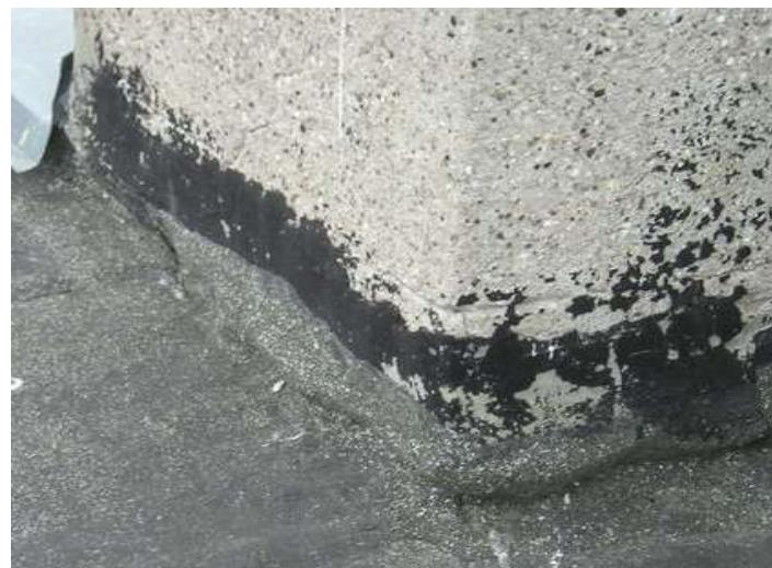
Рисунок 4 – Недостаточная высота заведения полотнищ к вертикальным поверхностям
