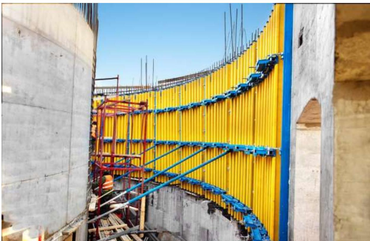
Рисунок 5 – пример радиусной опалубки
