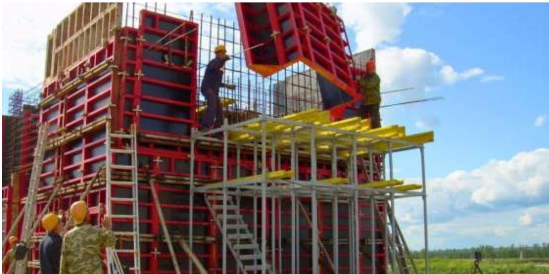
Рисунок 3 – пример объемно-переставной опалубки
