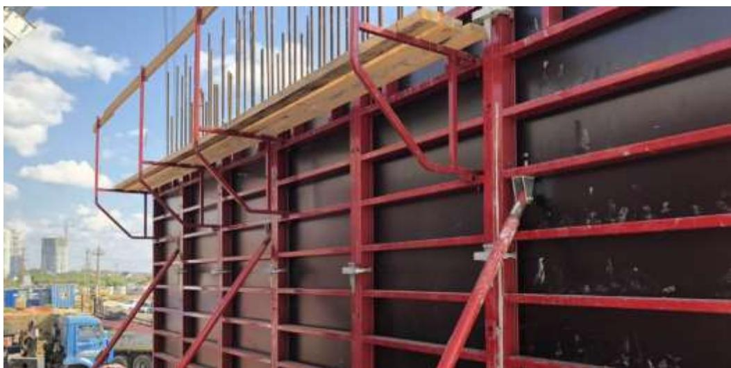
Рисунок 1 – пример крупнощитовой опалубки
