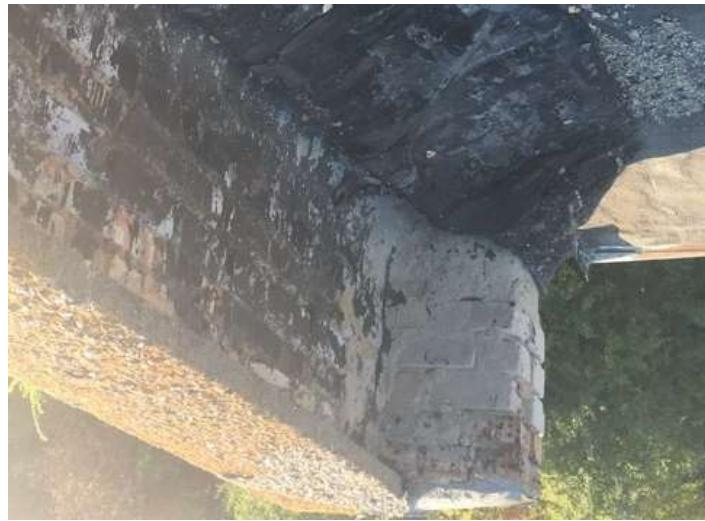
Рисунок 2 – Отслоение кровельного ковра от парапета
