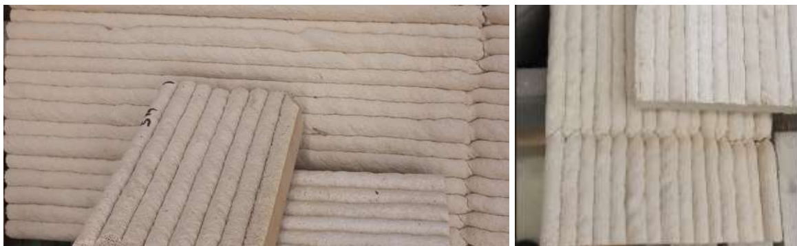
Рис. 1. Общий вид фрагментов 3D- печатной конструкции
