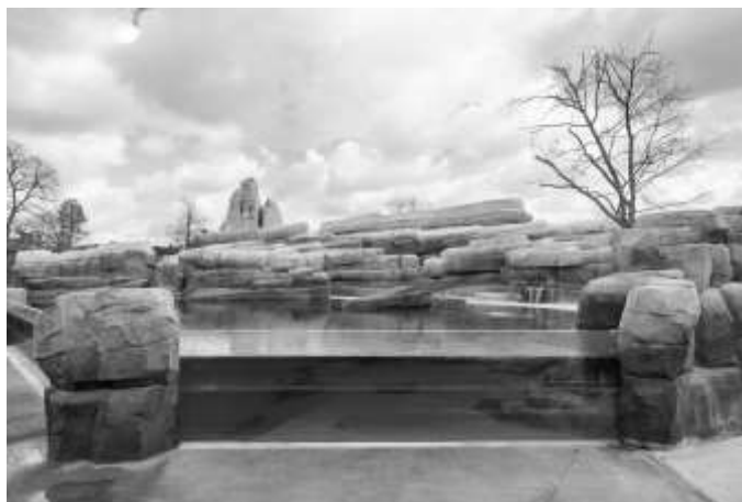
Рисунок 2. Аквариумы и подводные тоннели
