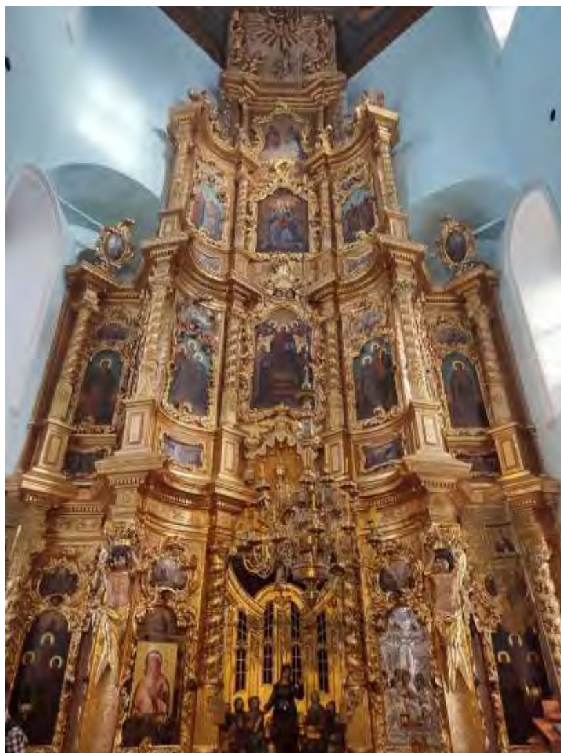
Рисунок 5 – Состояние алтаря здания
