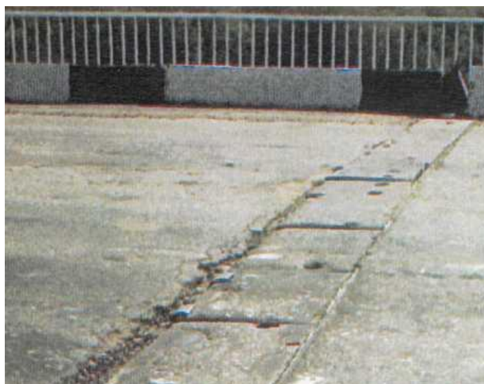
Рисунок 3. Деформационные швы. Разрушение околошовной зоны
