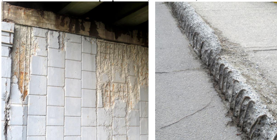
а б Рисунок 1. Морозное разрушение бетона подпорной стенки (а) и колесообойника (б) путепровода
