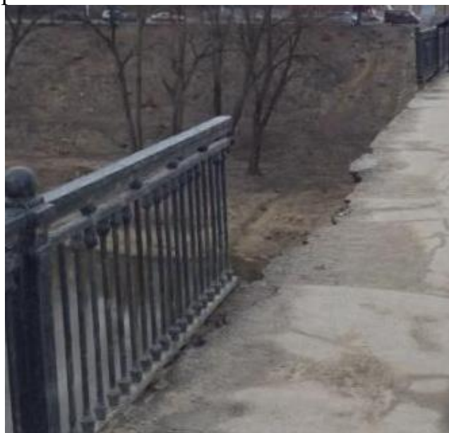
Рисунок 2. Разрыв ограждения моста
