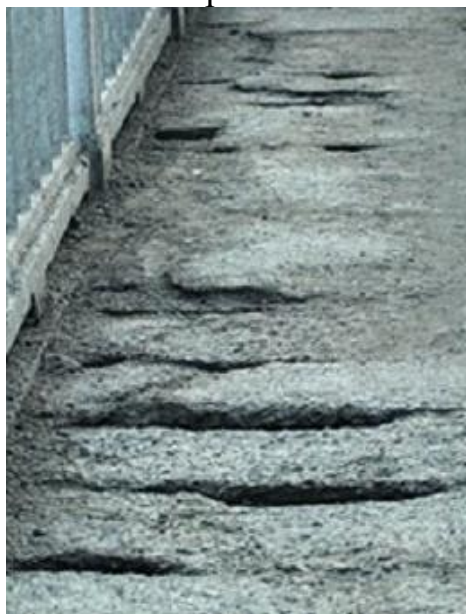
Рисунок 1. Повреждение тротуара, ограждения
