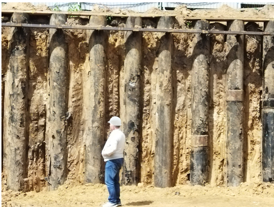
Подпорная стенка на строительной площадке 18-этажного жилого дома в Нижнем Новгороде. Общая высота стенки 14 метров (2023 год)
