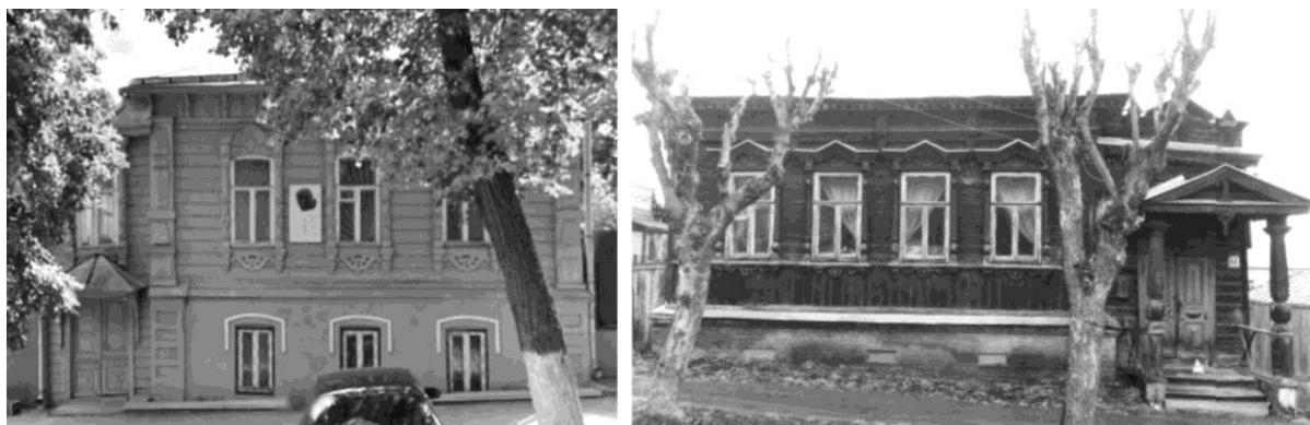
Рисунок 7 – Памятники культурного наследия (архитектуры) регионального значения: дома по ул. К. Маркса, 7 и Ключевского, 48
