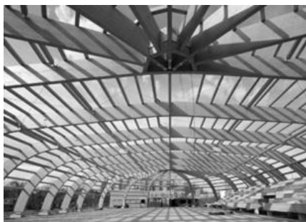
Рисунок 5 – Варианты большепролетных конструкций из гнутосклеёной древесины
