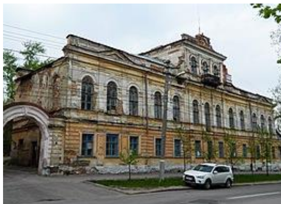
Рисунок 13 – Здание ОВО по Ленинскому району
