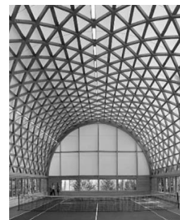
Рисунок 5 – Варианты большепролетных конструкций из гнутосклеёной древесины
