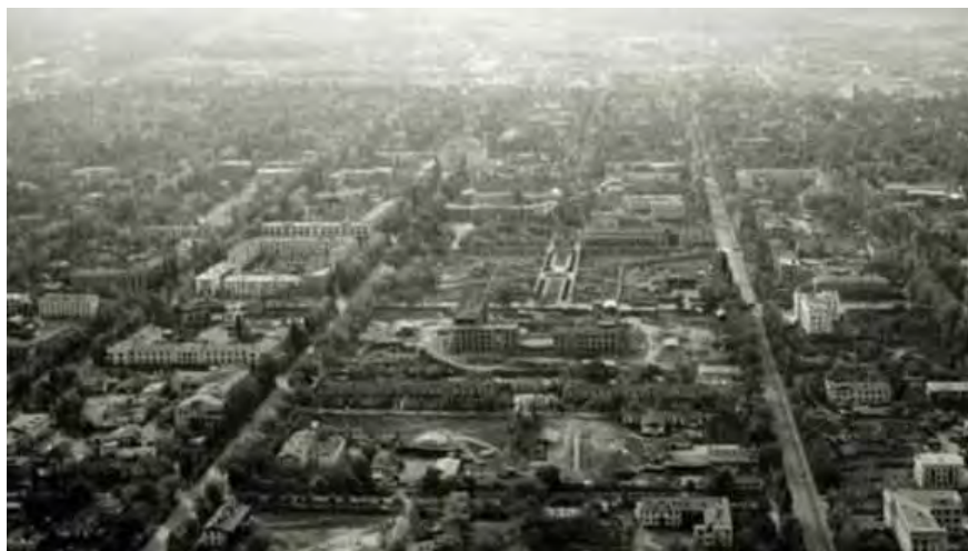
Рис. 1. Алматы 1952 г. Вид на строящийся дом правительства, ул. Панфилова (Красноармейская)
