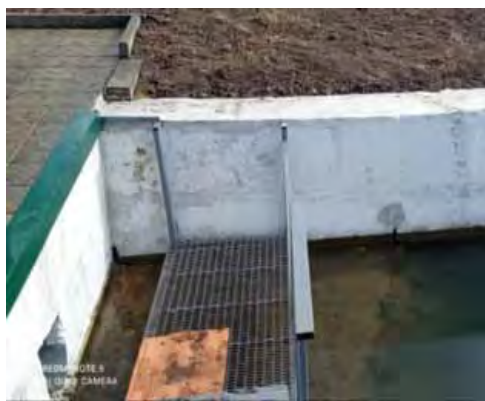
Рис. 4. Завершение реконструкции Спасского родника: (слева – направо) навес над родником; старый сруб вершинки, «обновленный» сверху досками; бетонная конструкция лотка с металлической лестницей
