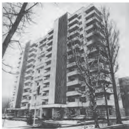
Рис. 4. 12-этажный жилой дом по ул. Карла-Маркса в Алма-Ате, возведенный из монолитного ж/б в объемно-переставной опалубке. Архитекторы Б. Чураев, В. Коханович, конструктор П. Медников
