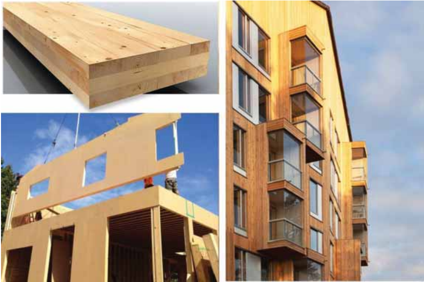
Рис. 1. CLT-плита, сборка дома из CLT панелей, деревянный восьмиэтажный дом в Финляндии от бюро OORPAA. Источник vithaus.ru
