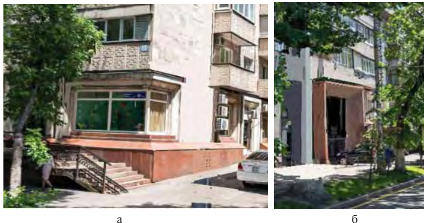
Рис. 5. Реконструкция фасадов типового жилого дома за счет разработки деталей зданий в стиле ретро с применением в отделке мрамора и гранита. Архитекторы Б. Чурляев, А. Коржемпо: а — фрагмент типового жилого дома с доработкой дизайна витрин, балконов, наружных лестниц и входов; б — гранитный портал входа во строенный магазин типового жилого дома
