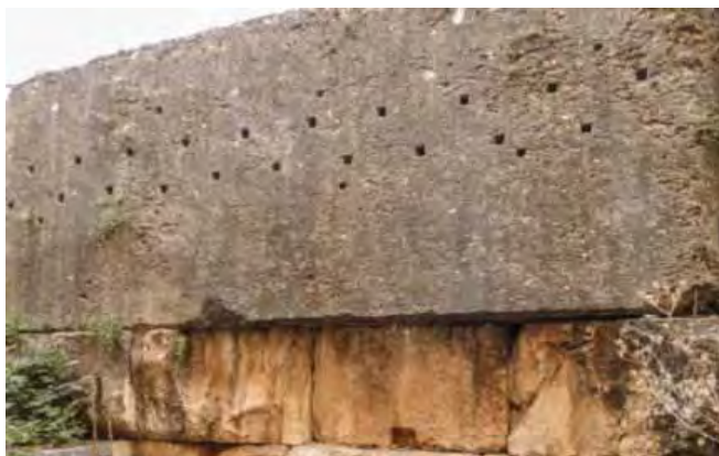
Рис. 7. Отверстия в блоках северного «Мегазабора» с внутренней стороны
