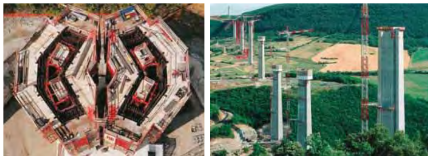
Рис. 2. Основные этапы возведения опор
