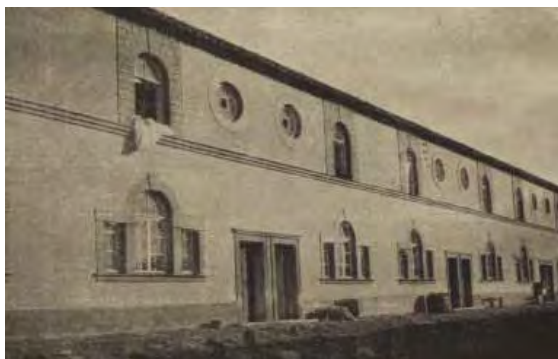
Рис. 6. Жолтовский И.В. Двухэтажный жилой дом для рабочих завода АМО, [1916]. Вид на главный фасад. Фотография [1923] года
