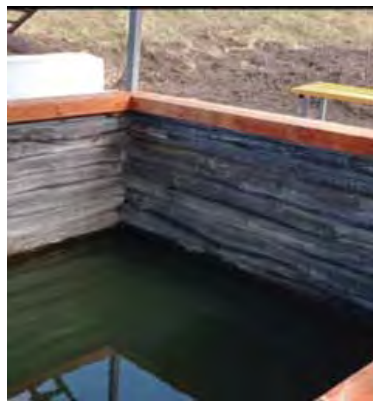
Рис. 4. Завершение реконструкции Спасского родника: (слева – направо) навес над родником; старый сруб вершинки, «обновленный» сверху досками; бетонная конструкция лотка с металлической лестницей
