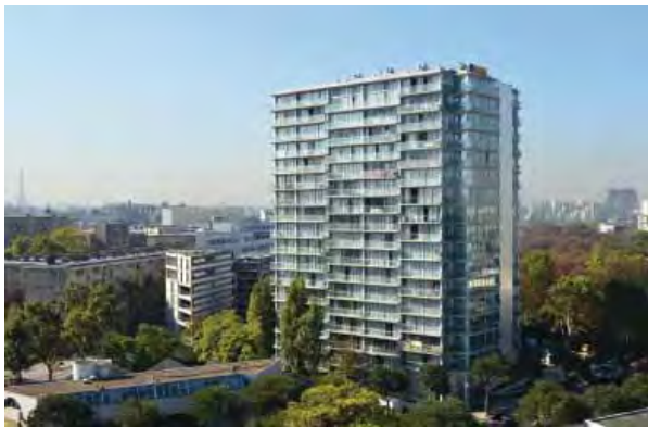
Вид башни после завершения реконструкции. Druot, Lacaton & Vassal
