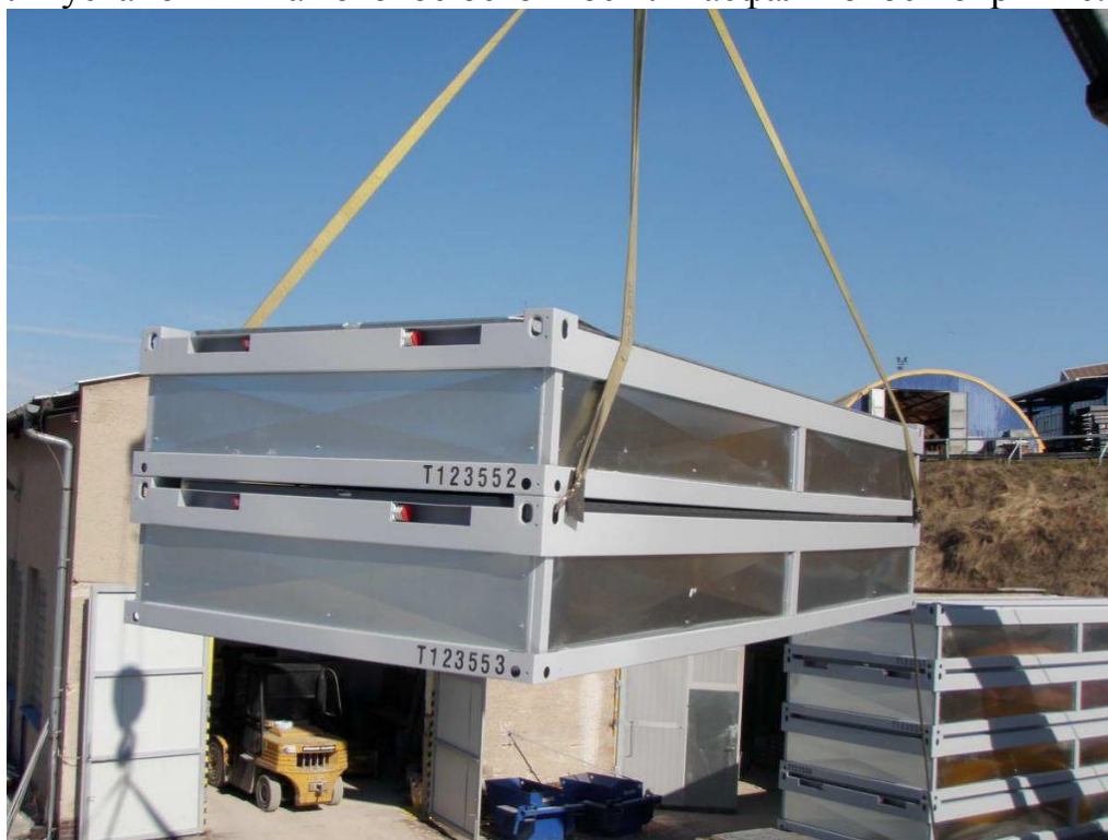
Рисунок 9 – Пример установки модуля Economy Line
