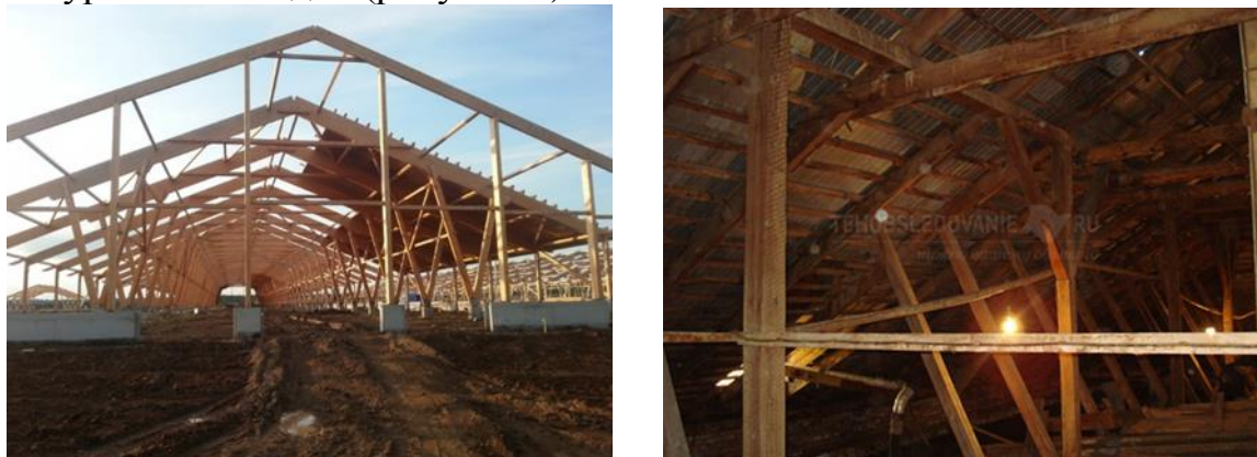
Рисунок 3. Применение деревянных конструкций с узловыми соединениями на клеенных шайбах в объектах животноводства, при реконструкции и реставрации
